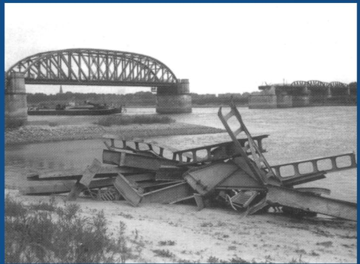
Blick vom westlichen Elbufer auf die zerstörte Elbbrücke. Die am Ufer liegenden Trümmerteile wurden aus dem Fluss geborgen. Ein Wiederaufbau der Brücke unterblieb, weil die Elbe zur innerdeutschen Grenze wurde.
